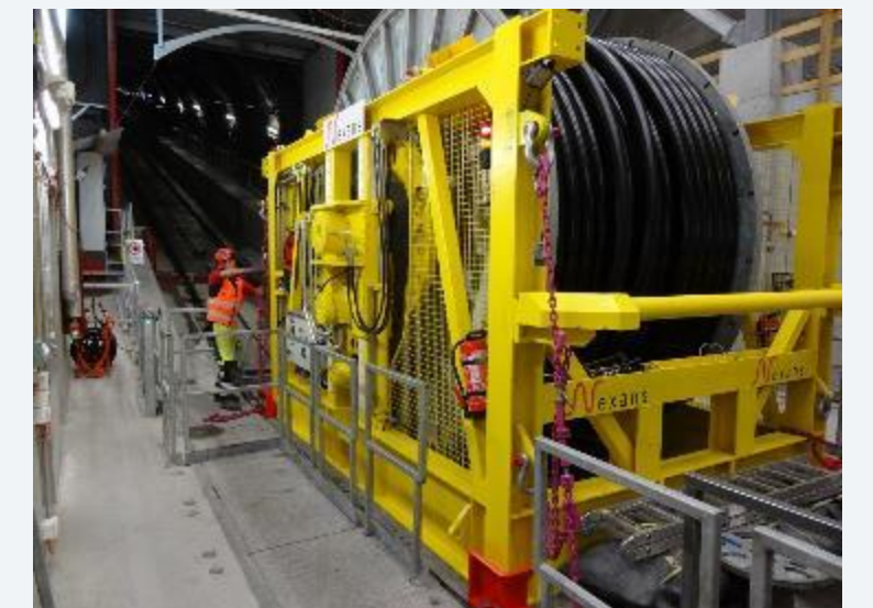
Limmern – Linthal AXPO
