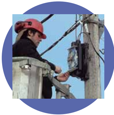
Zugangspunkte für Plug-in-Teilnehmeranschlusskabel
