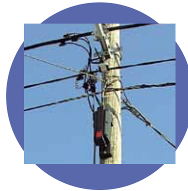
Zugangspunkte für gespleißte Teilnehmeranschlusskabel
