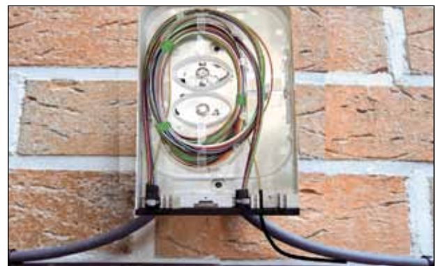
MCO-Dose und 5 mm-Außenrohr mit Nanokabel
