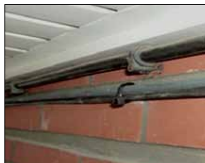
Primär- und Sekundärverteilerkabel
